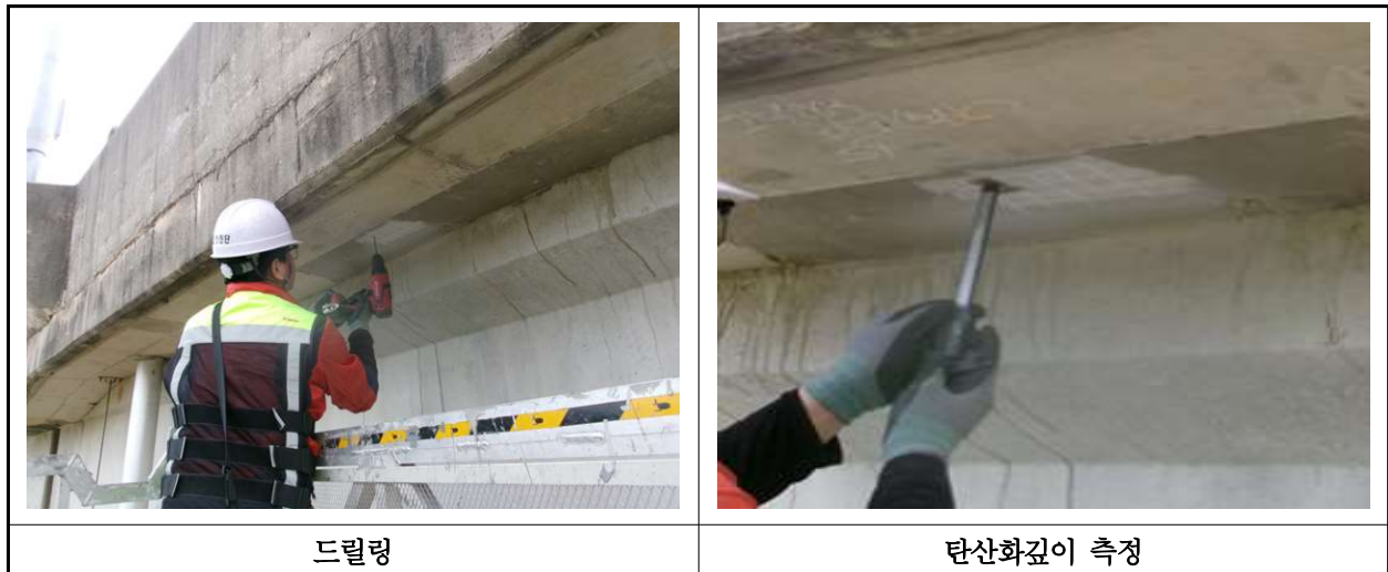
【사진 28.4.3】 탄산화 깊이 측정 현장사진
