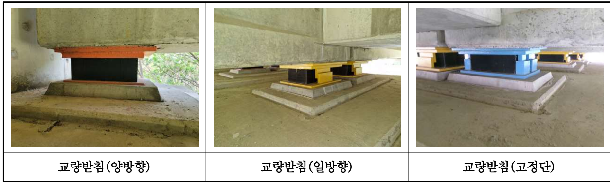
【사진 28.3.13】 교량받침 전경
