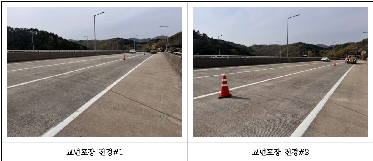
【사진 28.3.20】 교면포장 전경
