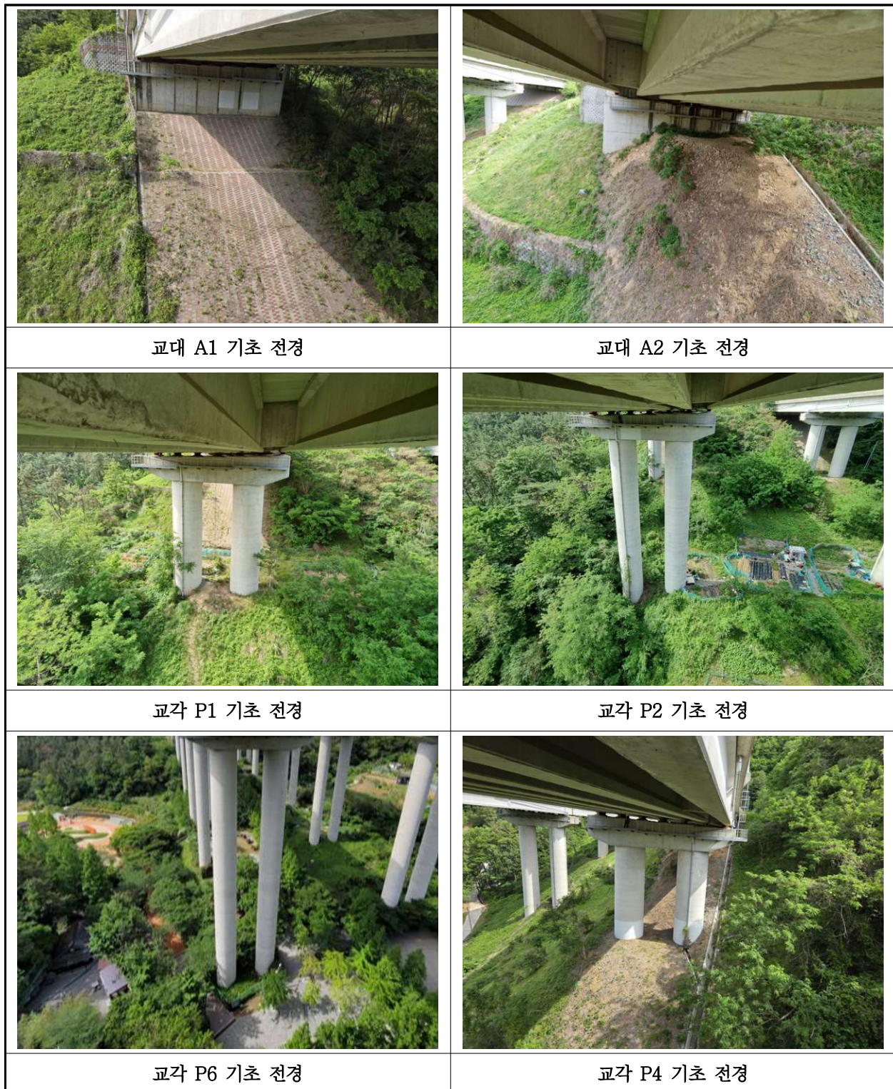
【사진 28.3.12】 기초 전경
