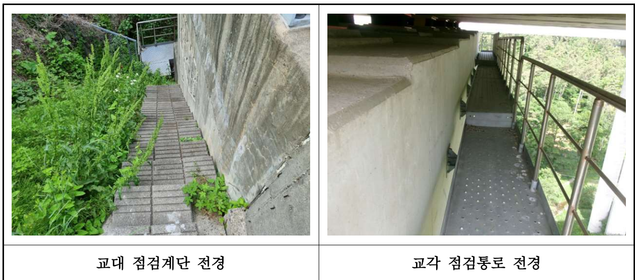
【사진 28.3.26】 교량 점검시설 전경
