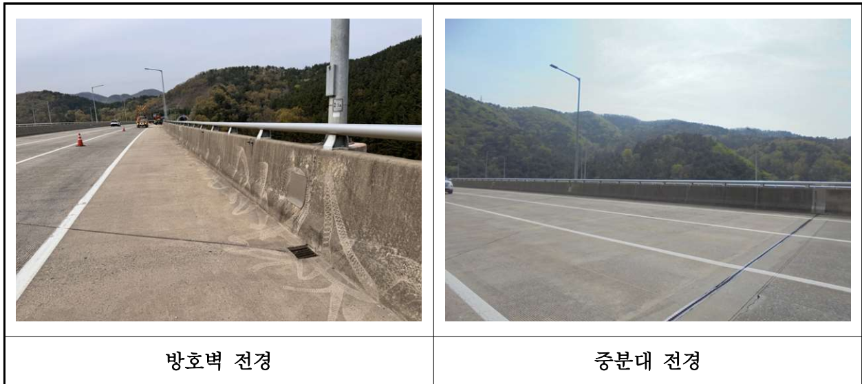
【사진 28.3.24】 방호벽 및 중분대 전경
