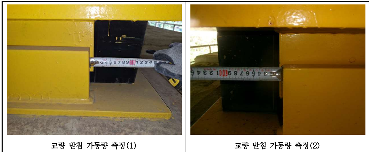
【사진 28.3.16】 교량받침 이동량 측정
