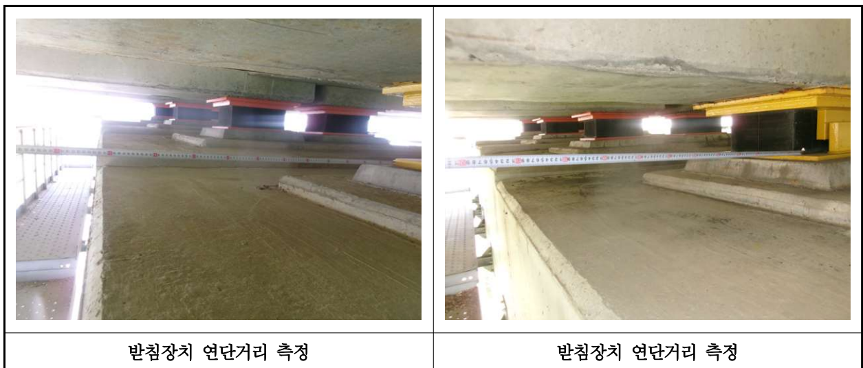
【사진 28.3.15】 교량받침장치 연단거리측정
